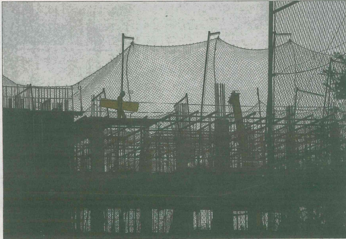
Trabajos de construcción de un edificio en la Gran Vía de Barcelona. / ALBERT GARCIA
